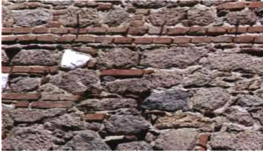
Resim 30- Yatay tuğla sırası bulunmayan, homojen görümlü ve 2 sıra tuğla hatıllı, tuğla-taş moloz duvar örgüsü (Soğandere S. No: 11)
