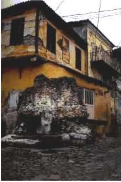
Resim 14- Hıms tekniğinde geleneksel Türk evi ile Batı etkili kargir evler yanyana
