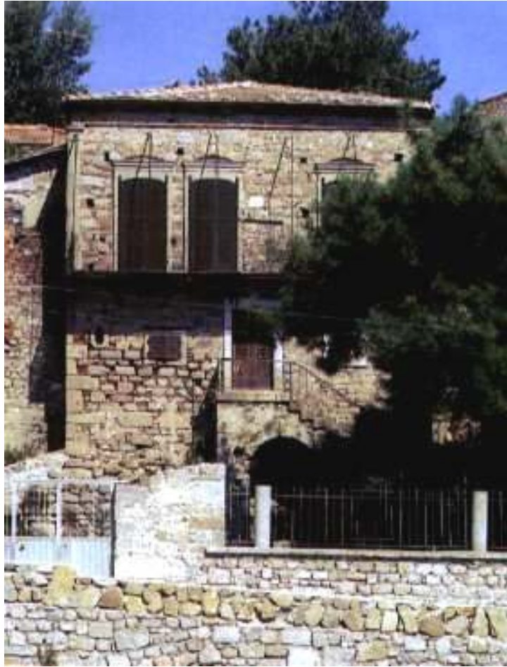
Resim 26- Zemin ve üst katta aynı duvar işçiliğinin uyguladığı, cepheleri sıvasız bir ev
