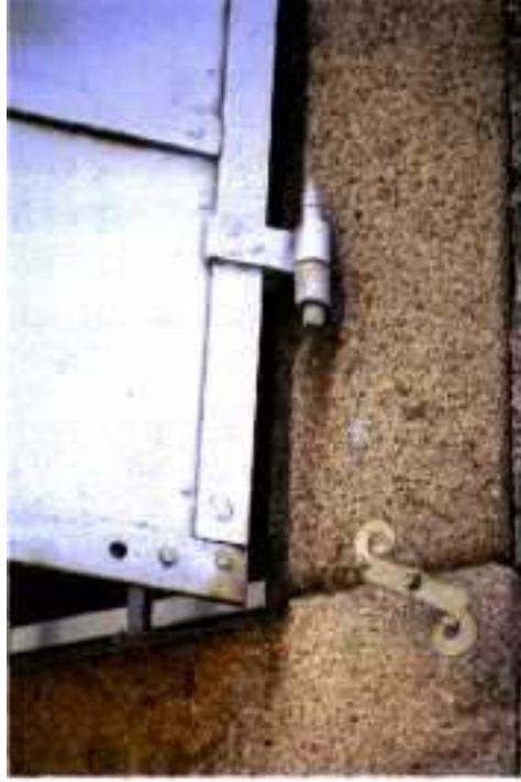
Resim 95- Kepenkler açıldığında kullanılan kelebek lamalar (Dede S. No: 44)
