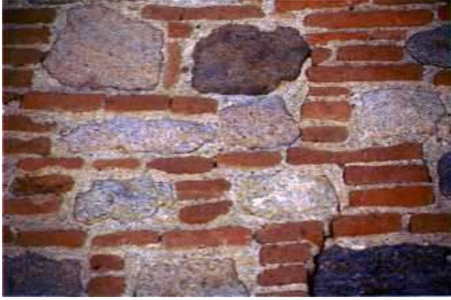
Resim 29- Yatay tuğla sırası sürekli olmayan, 1 sıra taş-1 sıra tuğlalı düşey ve 1 taş-3 sıra tuğlalı yatay almaşık sistemlerin birlikte kullanılmasıyla oluşan sistem (Soğandere S. No: 28)
