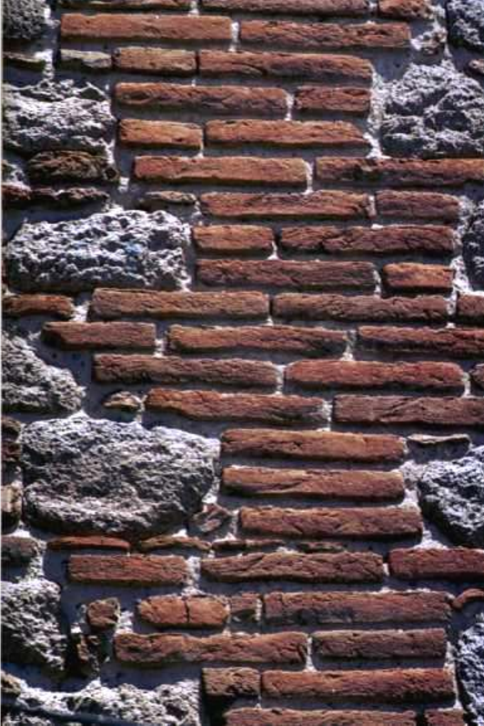
Resim 31- Sıvasız dış duvarlarda, iki katta da devam eden tuğla dekorasyonu
