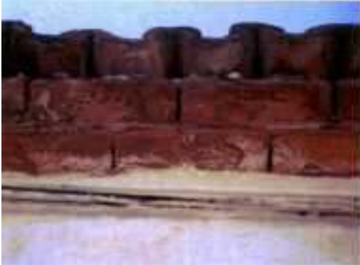
Resim 33- Vakıfbahçe S. No: 8
