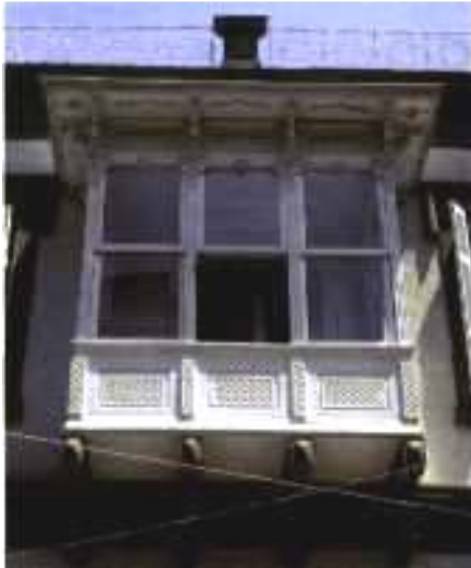
Resim 107, 108, 109, 110- İzmir'deki Sakız Tipi Evlerin karakteristik ahşap cumbalarında saçak, pencere, parapet ve konsol bezemeleri. Bergama'daki sakız tipi evlerin cumbalarında bu nitelikte süslemelere pek rastlanmaz. Ancak Buca ve İzmir'deki standart paraçol tiplerinden biri, Bergama'da da kullanılmıştır.
