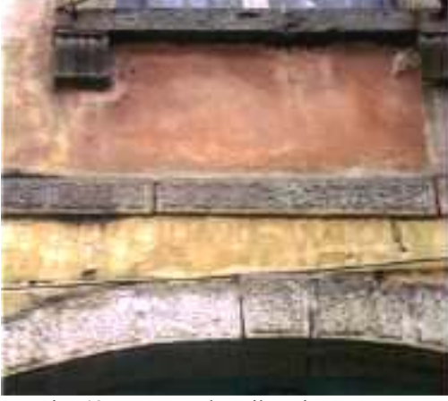
Resim 48- Düz - taş kat silmesi (Dede S. No: 23)
