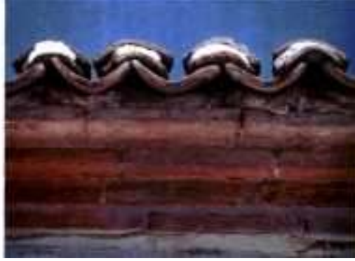
Resim 34- Vakıfbahçe S. No: 17
