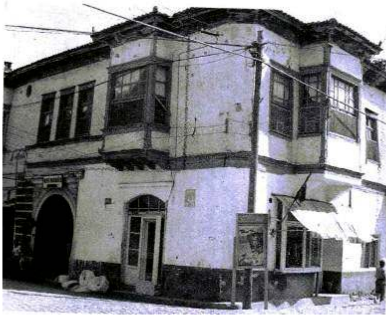
Resim 2- Kafesli Ev'in aynı açıdan 1970 yıllarındaki görünüşü (Fotoğraf: Reha Günay)
