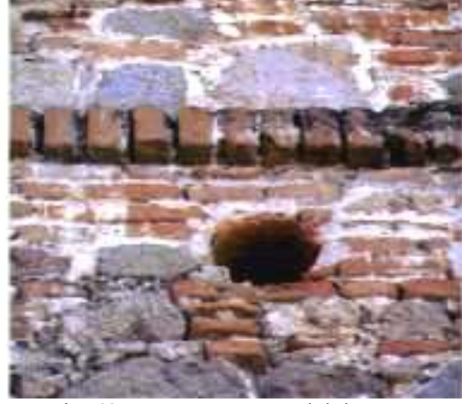
Resim 49- Düşey - yarım tuğlalı kat silmesi (Akşam Kız Sanat Okulu)
