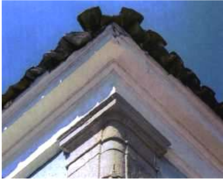
Resim 47- Köşe-başı evlerde saçak silmesi dönüşü (Soğandere S. No: 49)
