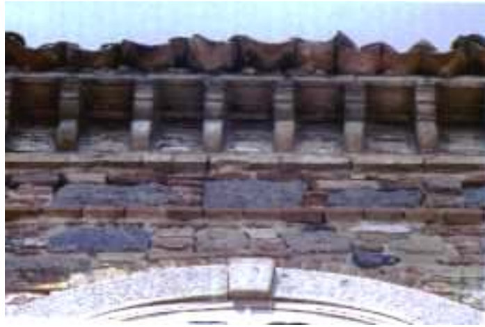
Dişli ve Konsollu Saçak Düzenlemeleri
