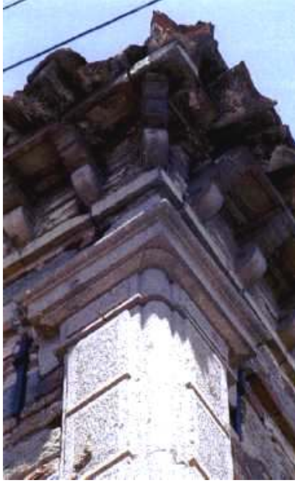
Resim 53- Köşelerde iki yönlü pilaster ve saçak silmesi ilişkisi (Kadı Çıkmazı No: 2)
