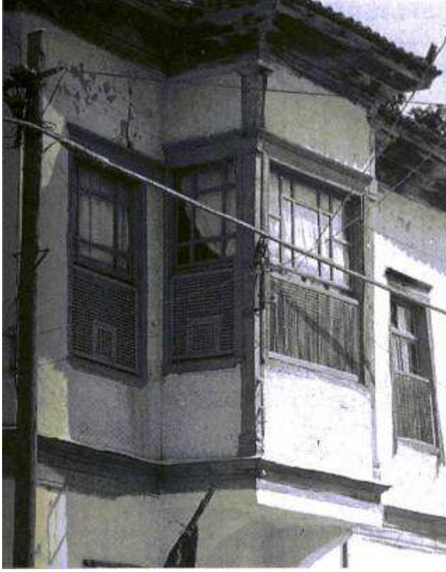
Resim 3 - Mehmet Bey Konağı'nın Kafesli Ev adıyla tanınmasına neden olan kafesli cumba ve pencereler. (Fotoğraf: Reha Günay)
