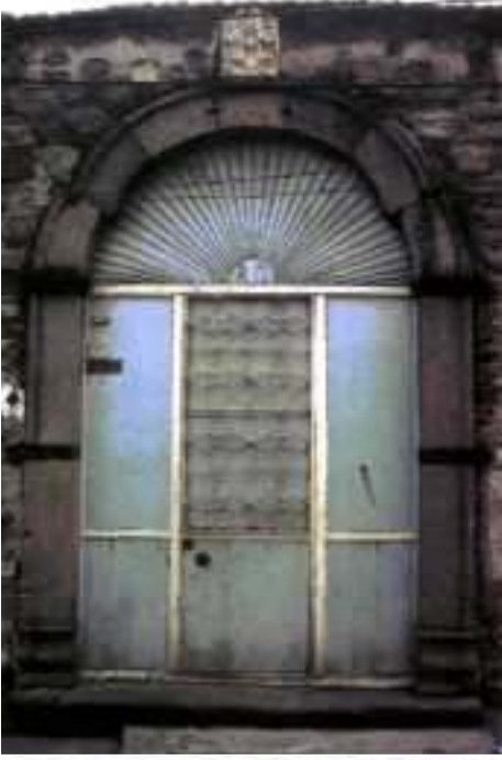
Resim 69- Giriş kapılarında sık rastlanmayan üç bölümlü/tek kanatlı düzen (Kadı S. No: 1)
