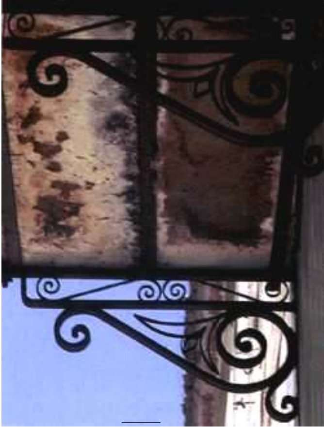
Resim 57- Bergama evlerinde kullanılan 2. tip paraçol (Dündar S. No: 6)
