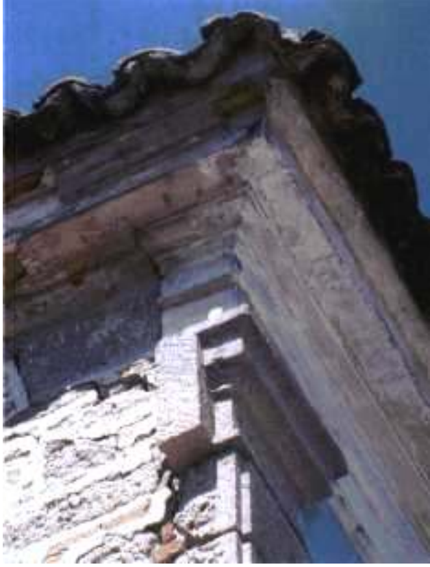
Resim 46- Bitişik düzenli evlerde saçak silmesinin yan cepheye dönüşü (Soğandere S. No: 11)
