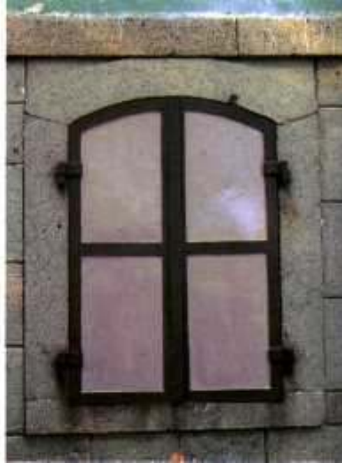
Resim 82- Üst kattakilerle aynı, ancak Domuz yüksekliği az olan bodrum kat penceresi (Soğandere S. No: 2-49)
